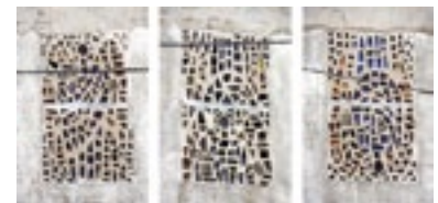
■ Vidrieras en Fuente Caldera, Granada. La primera correcta, la segunda intercambiada de posición y la tercera invertida [MCS]
