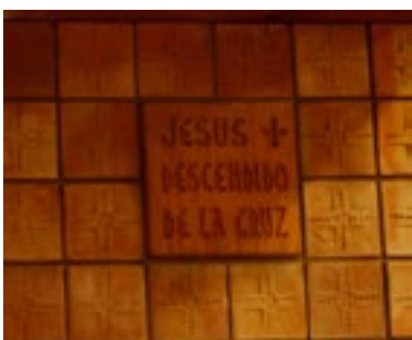
Revestimiento cerámico y placas del Vía Crucis en la capilla del colegio de Santa Teresa [Foto MB, Archivo MUA]
